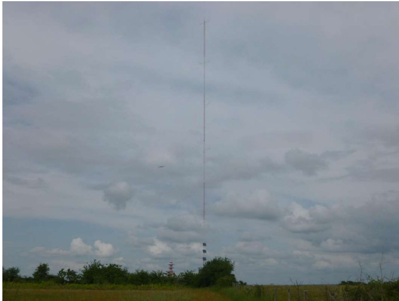
Photographie 21 : Mât de mesures installé dans la zone d'implantation potentielle (Source : ENCIS Environnement)
