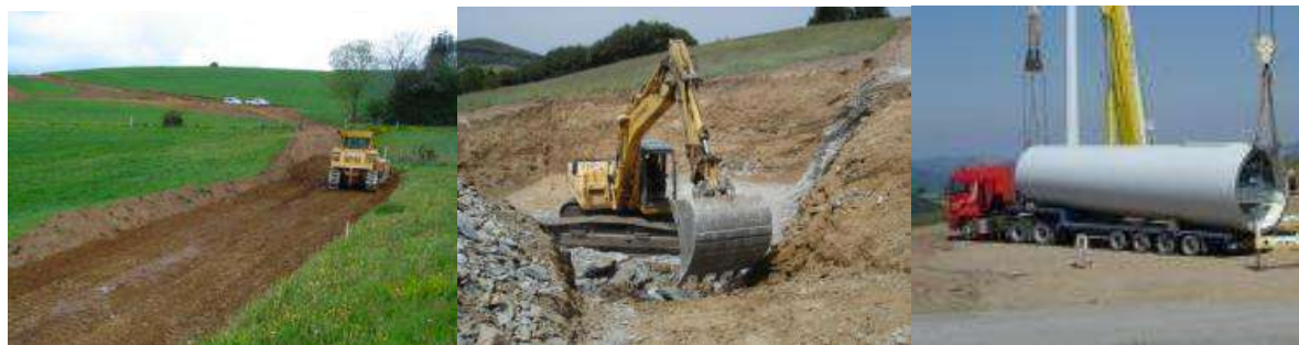
Photographie 33 : Illustration d'un chantier éolien (Source : ENCIS Environnement)
