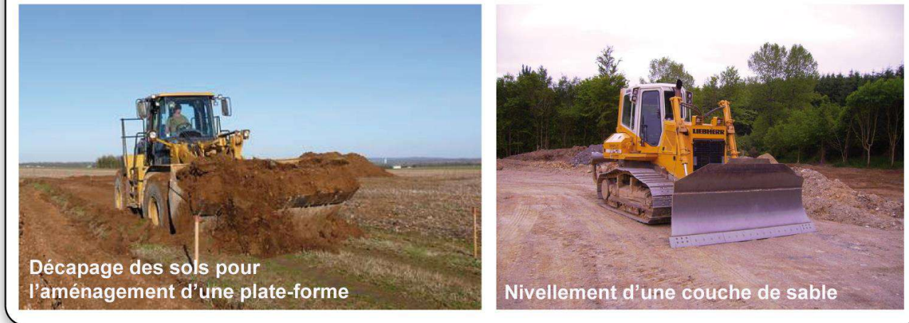
Photographie 24 : Exemples d'engins de travaux de VRD
