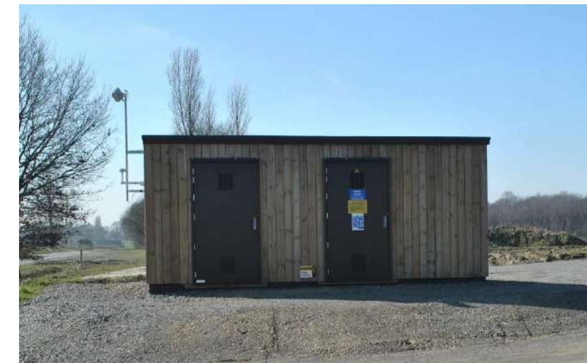
Photographie 43 : Exemple d'intégration d'un poste de livraison (Source : ENCIS Environnement)
