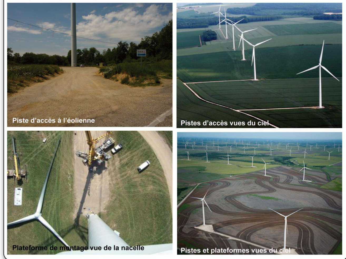
Photographie 23 : Exemples de plateformes de montage et de pistes (Source : ENCIS Environnement)
