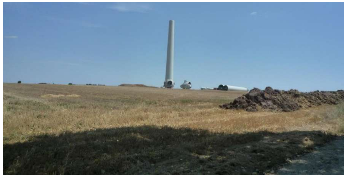
Photographie 30 : Exemple de stockage de terre durant un chantier éolien (Source : ENCIS Environnement)
