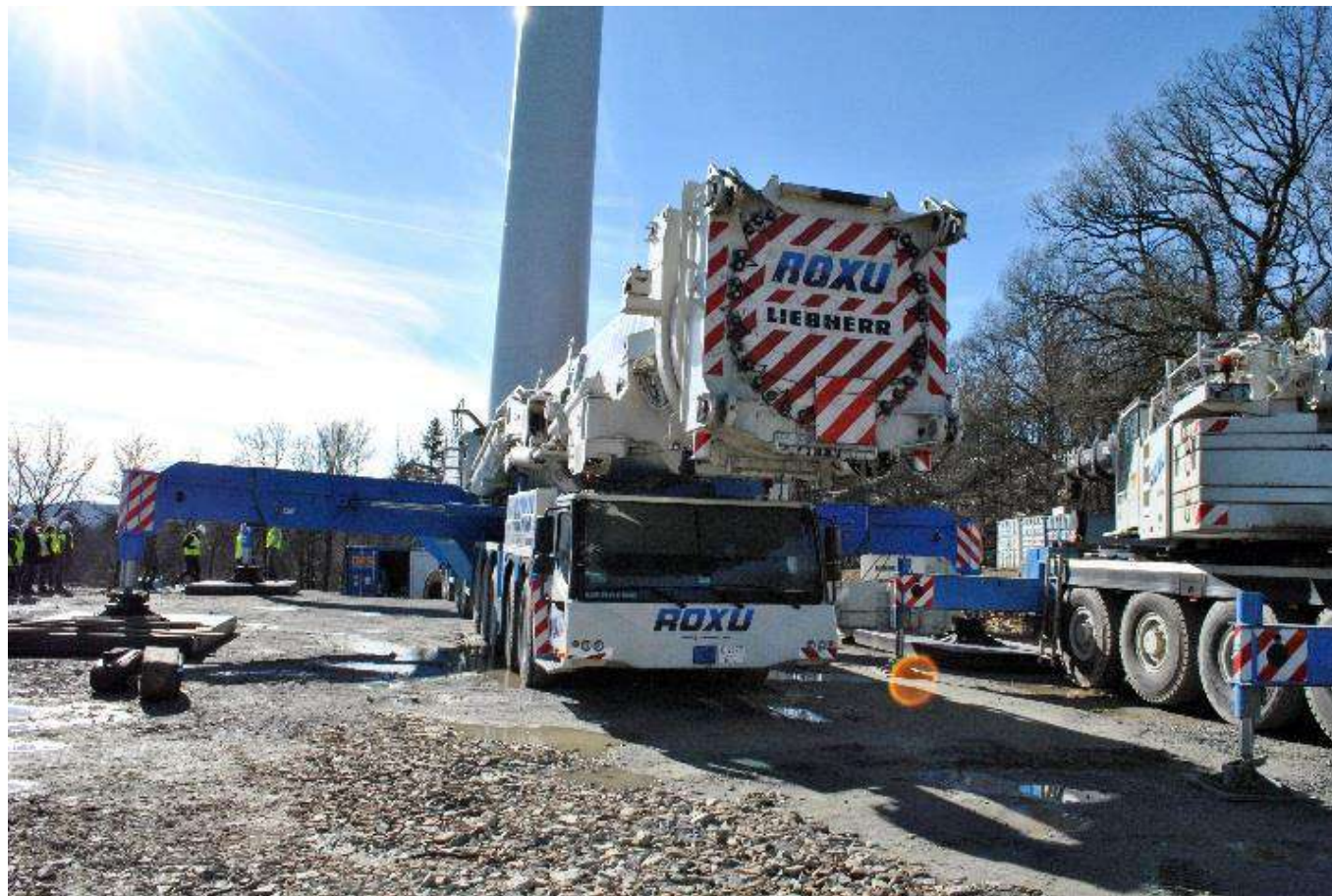
Photographie 22 : Exemple de plateforme de montage et de grue (Source : ENCIS Environnement)
