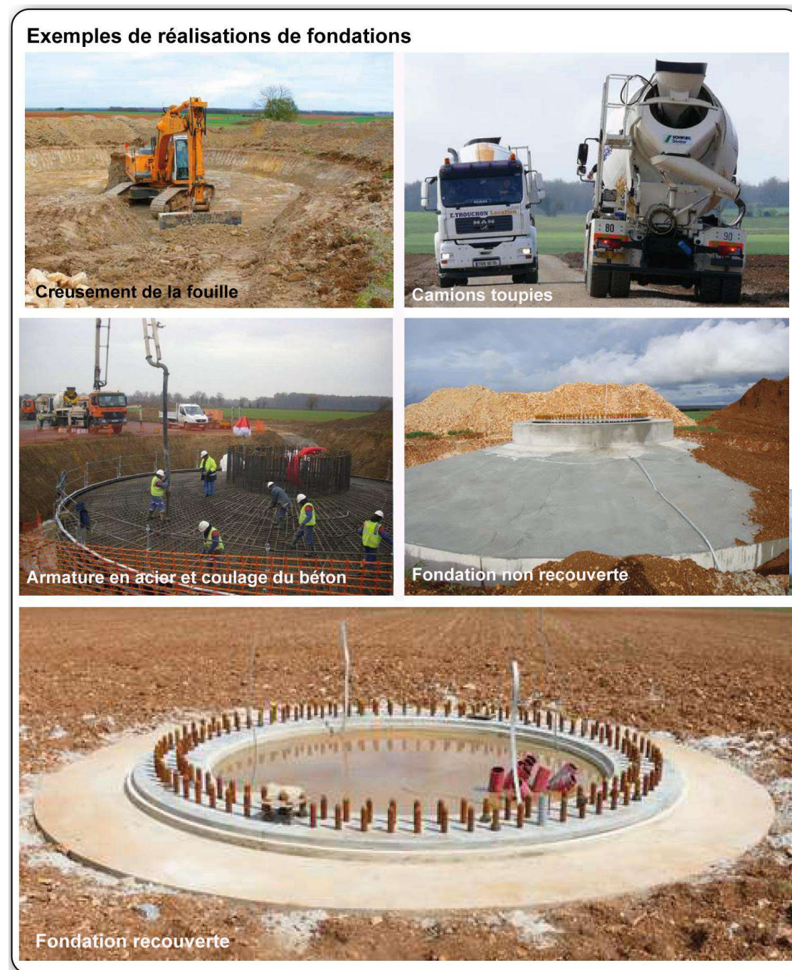
Photographie 25 : Etapes de réalisation d'une fondation d'éolienne
